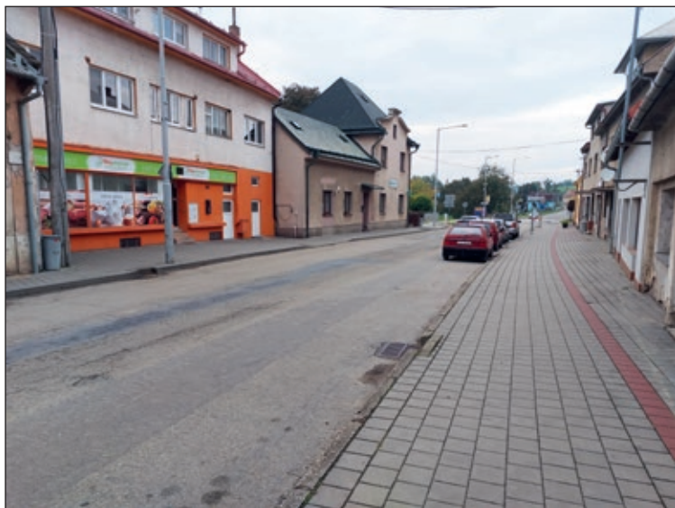
Chodník ve Zborovské ulici se zúží ve prospěch podélných parkovacích stání.
