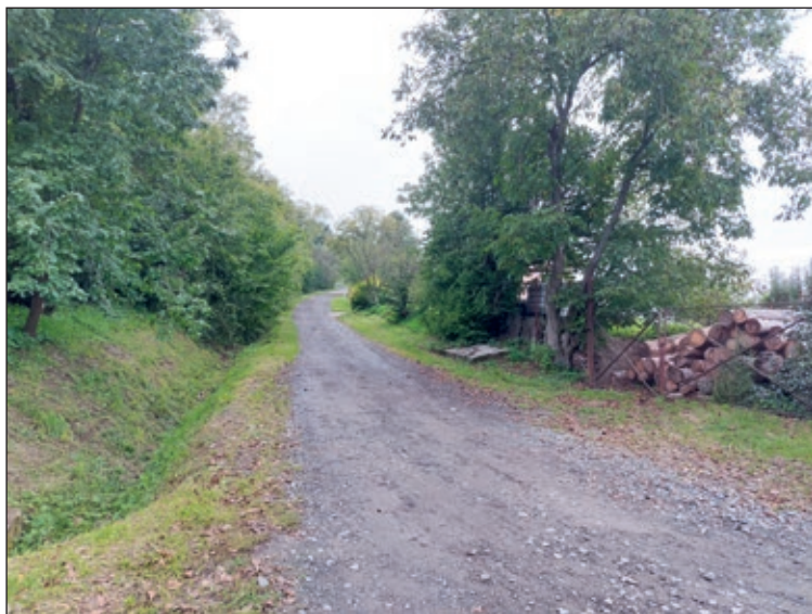
Zpevněná komunikace Ke Kašnici (září 2022)
